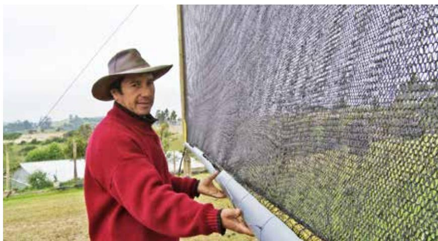
La malla utilizada es de polipropileno, denominada malla sombra o malla Raschel. El atrapaniebla debe quedar en posición perpendicular a la dirección dominante de desplazamiento de la niebla para una absorción máxima. Este sistema permite también la captación del agua de lluvia.
