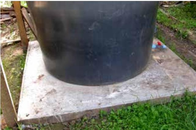
Se recomienda instalar el estanque sobre una base de hormigón calculada para que soporte el peso del estanque lleno de agua. Considerar que 1.000 litros de agua equivalen a 1.000 kilos.
