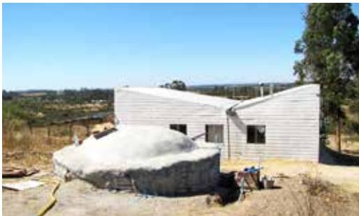
El estanque semienterrado permite que la fuerza que ejerce el agua contenida en su interior se compense con la fuerza que ejerce el suelo hacia el estanque. De esta manera, existe menos riesgo de que colapse por la presión que ejerce el agua. En la imagen se aprecia un diseño de casa con un techo que facilita la concentración del agua de lluvia en una canaleta central.
