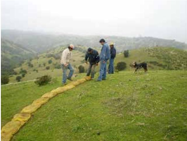
Este es un ejemplo sencillo de captación de agua de lluvia en el suelo. Se utilizan barreras físicas, que se ubican en curvas a nivel y en forma perpendicular a la dirección de la pendiente del terreno. Las barreras físicas pueden ser sacos con tierra llenos hasta la mitad. Al ser ubicados en curvas de nivel en un terreno en pendiente, reducen la velocidad de escurrimiento superficial del agua, evitan con ello la erosión y facilitan la infiltración y acumulación del agua en el suelo.
