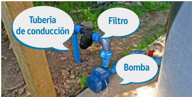
Partes de un sistema de riego:
